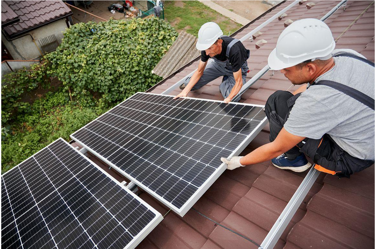
Installatie van zonnepanelen op een dak
