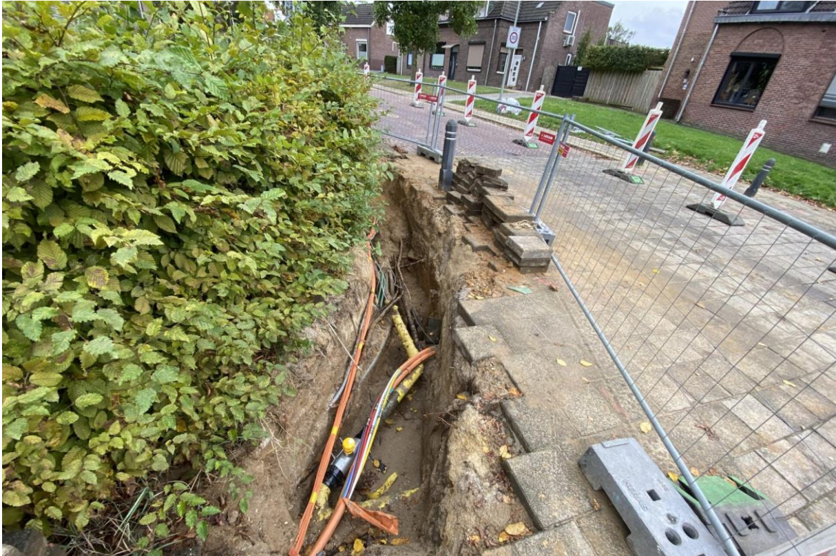
Grondwerk aan gasleidingen in een straat.
